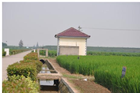
——灌溉系统。在耕作方内形成较为独立的灌溉系统，做到统一灌水、统一排水，分片灌溉。每个耕作方在邻近中心河或生产河处规划布设1座泵站，泵站从中心河或生产河提水到农渠，再经农渠输送到格田。规划新建电灌站100余座，并修建配套出水池百余座和相应配套设施。
