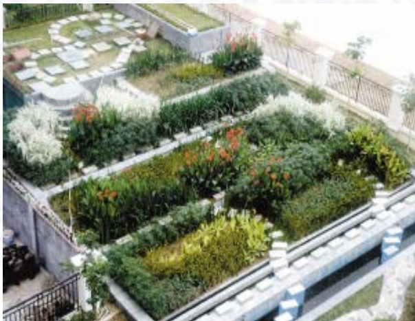
（深圳龙岗人工湿地污水处理系统处理居民生活污水）
