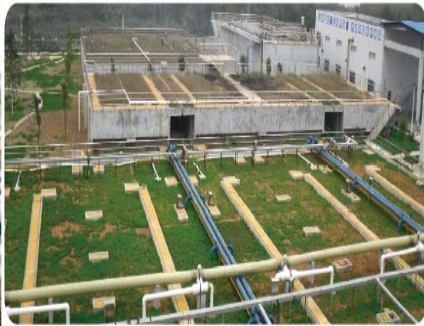
（岳阳云溪化工工业园污水处理厂-人工湿地）
