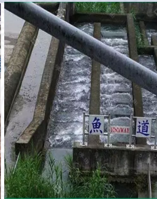
修建过鱼设施
