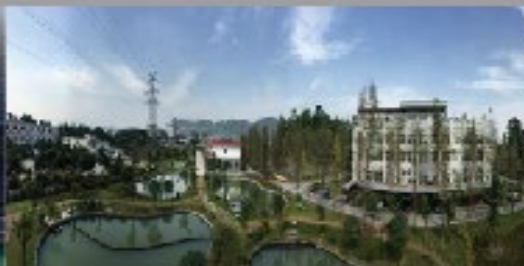
电建大渡河安谷 增殖站
